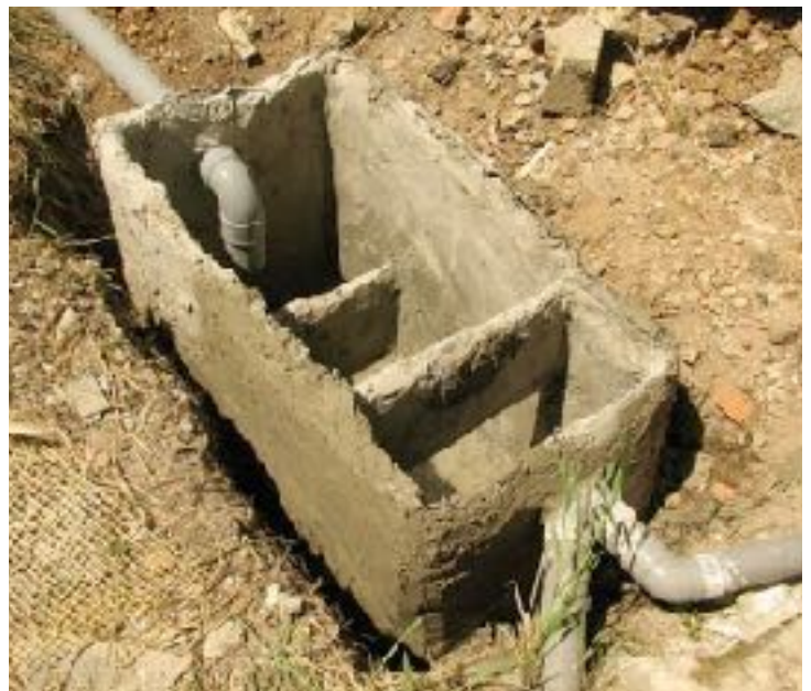
ANNEXE 3.3 : STRUCTURE APRÈS ENDUITS DE CORPS ET D'ÉTANCHÉITÉ
