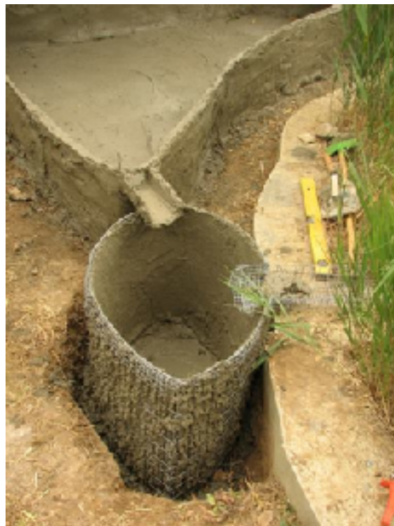
BASSIN > PHOTO 5 : ENDUIT DE CORPS DE LA STRUCTURE
