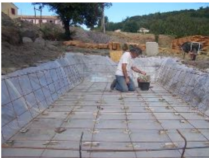
PHYTO BÂCHE > PHOTO 6 : MAILLAGE 40 X 40CM ET FERS À BÉTON DE 6MM
