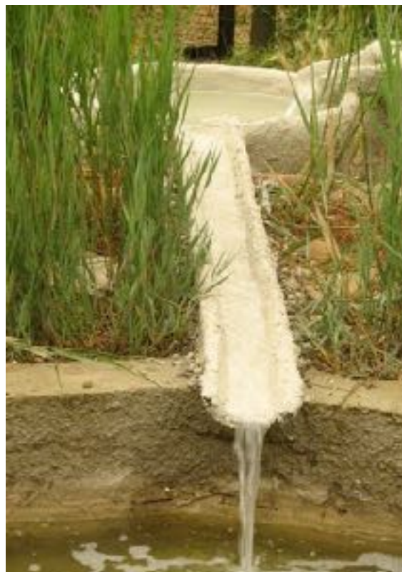
BASSIN > PHOTO 7 : CANAL ENTRE LES BASSINS DE FILTRATION (PHOTOS 4 À 6) AU BASSIN PRINCIPAL (PHOTOS 1 À 3)
