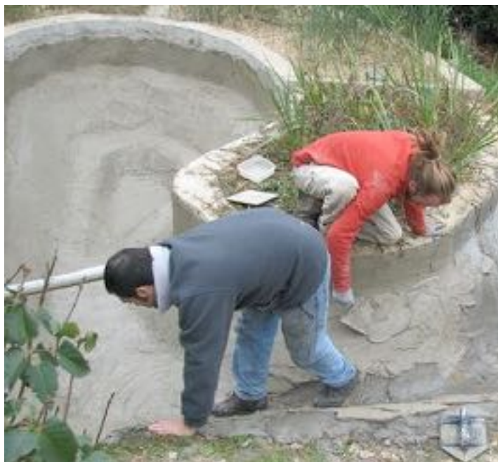
BASSIN > PHOTO 2 : 2ÈME COUCHE (=ENDUIT D'ÉTANCHÉITÉ)
