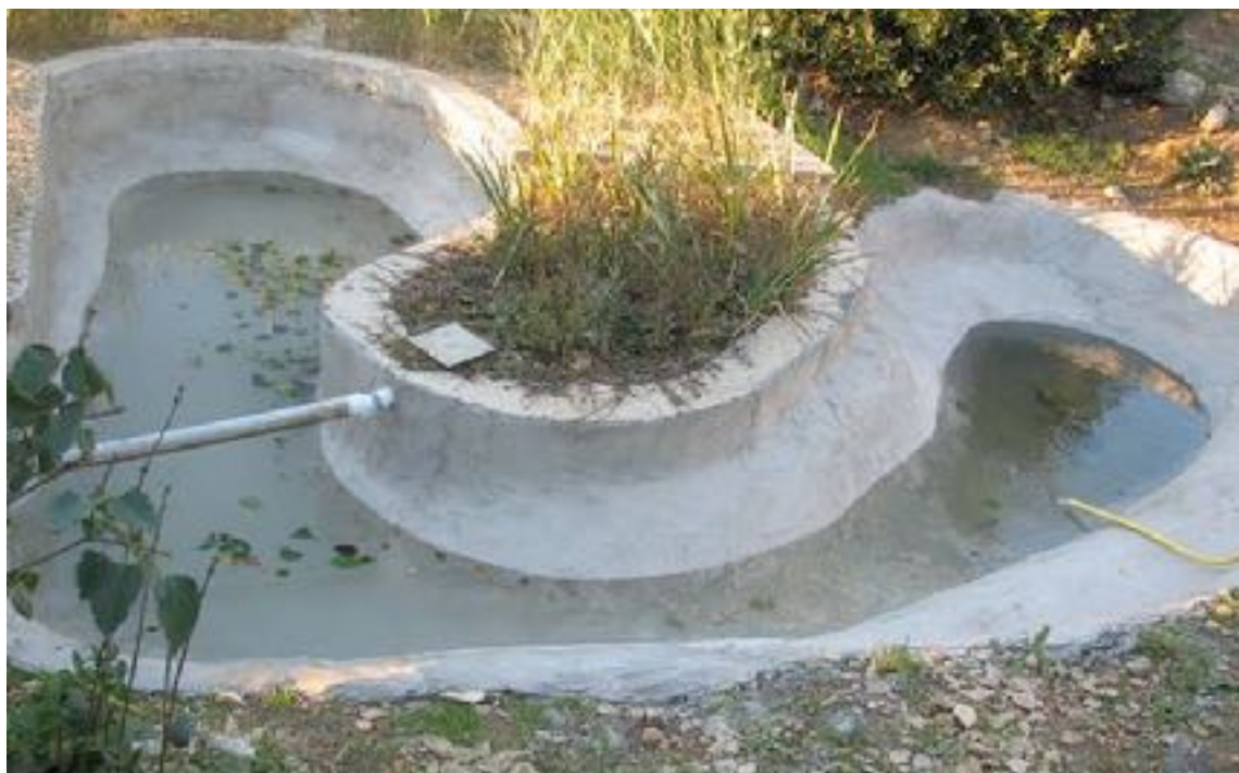
BASSIN > PHOTO 3 : MISE EN EAU
