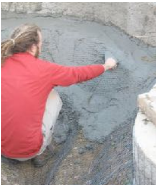
BASSIN > PHOTO 1 : POSE DES GRILLAGES ET ENDUIT DE CORPS
