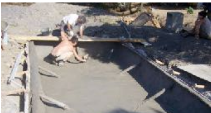
PHYTO BÂCHE > PHOTO 10 : 2ÈME COUCHE (ENDUIT CORPS ?)
