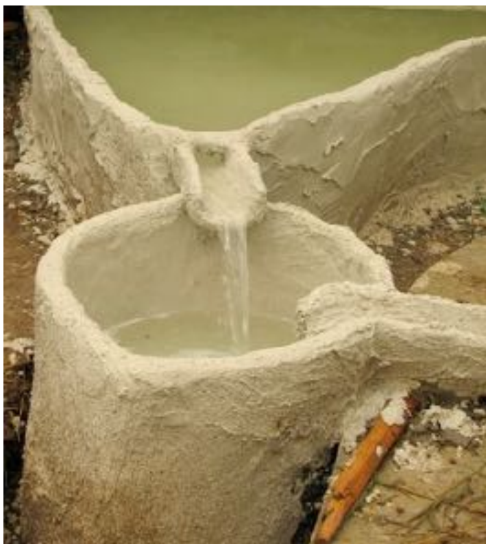
BASSIN > PHOTO 6 : 2ÈME COUCHE (=ENDUIT D'ÉTANCHÉITÉ) AVEC DU CIMENT BLANC
