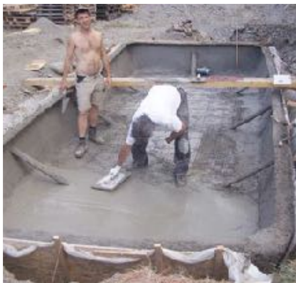
PHYTO BÂCHE > PHOTO 9 : ENDUIT DE CORPS (SUR LE FOND)
