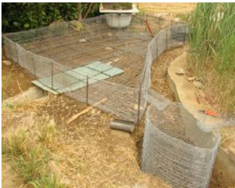
BASSIN > PHOTO 4 : BASSINS EN AMONT. STRUCTURE GRILLAGÉE (2 BASSINS ET 2 CANAUX)
