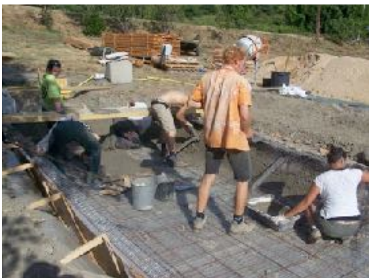
PHYTO BÂCHE > PHOTO 8 : ENDUIT DE CORPS (SUR LES CÔTÉS PUIS LES JAMBES DE FORCE)
